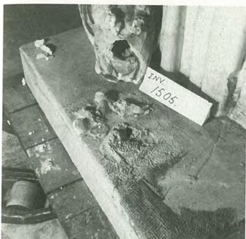
Fig. 4. Sokkel med afbrækket ugle fra afstøbningen af Athena-Medici (440-430 f.Kr.). Mindst en centimeter gips er skyllet væk.
